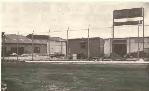
Actualmente tin hopi actividad di construcion den zona libre cual ta un indicacion di e gran interes comercial cu ta existi pa e zona aki. Tanto Gobierno Insular y algun comerciantenan local ta construyendo den e zona libre.
